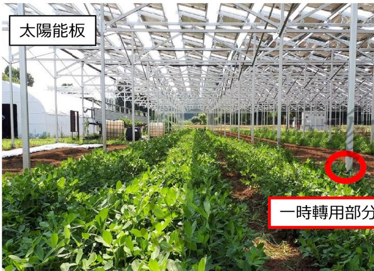
營農型太陽能發電設備實例
